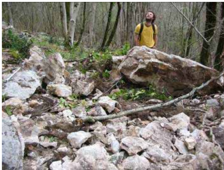
A gauche, rocher instable nécessitant d'être purgé pour la mise en sécurité du site. A droite, la personne donne l'échelle des blocs mis à bas lors de la purge à Aigues-Juntes. Attention cependant, la purge de blocs d'une telle taille n'est pas fréquente.
